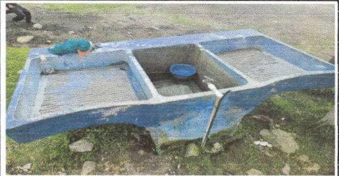
Foto 8: La plia actualmente se encuentra fisurada por lo que es necesario sustituirla.
