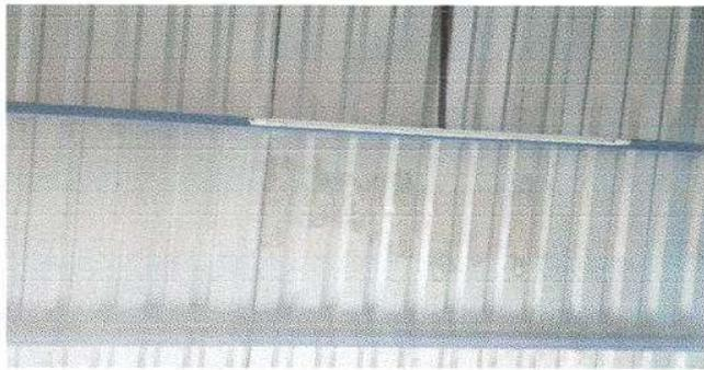
Foto1: Sustitución de lámina troquelada Aluzinc calibre 26 por Lamiluz
